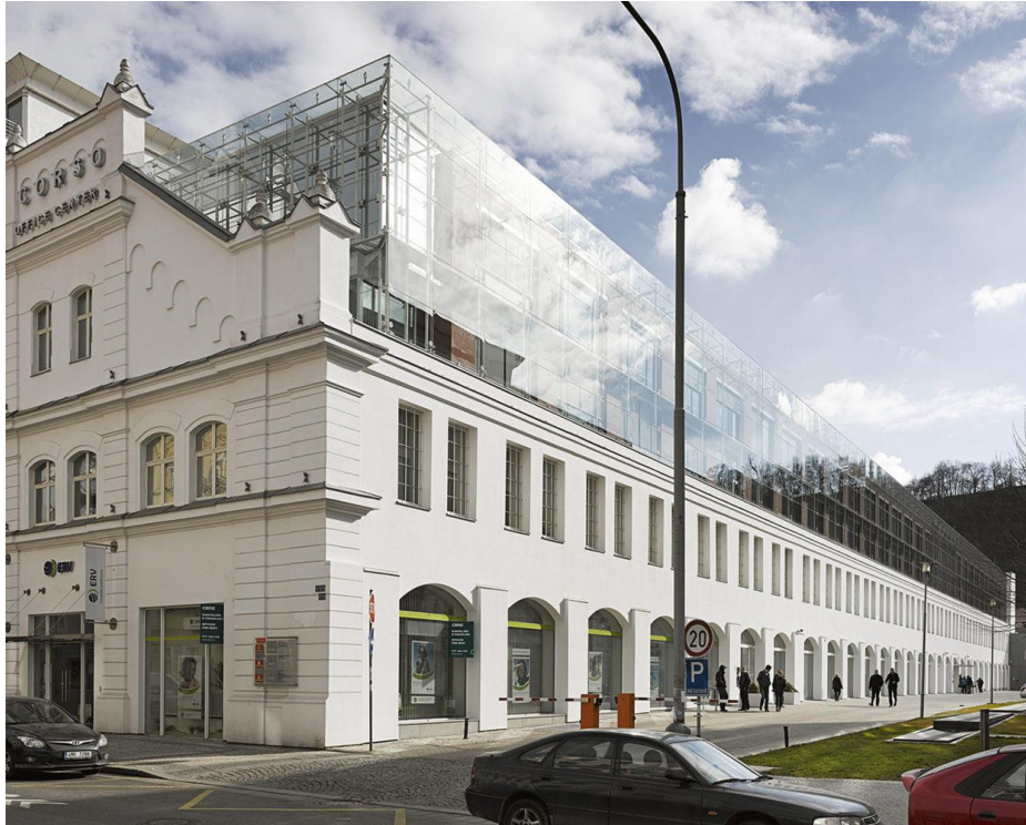
Fotografia 10 Szklana fasada dobudówki na dachu starego budynku Źródło: www.archdaily.com dostępna dnia 25.10.2023
