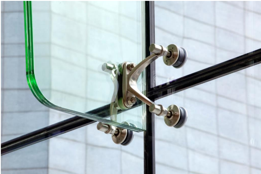
Fotografia 21 Łącznik punktowy
