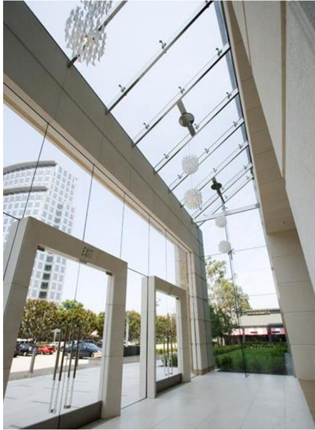
Fotografia 8 Szklana konstrukcja żebrowa zadaszenia przedsionka Źródło: www.structuralglass.com dostępna dnia 25.02.2023
