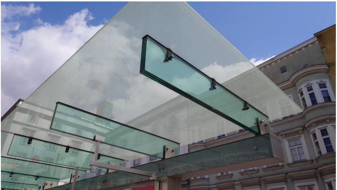
Fotografia 7 Szklany przystanek autobusowy - Linz 2023. Zdjęcie własne
