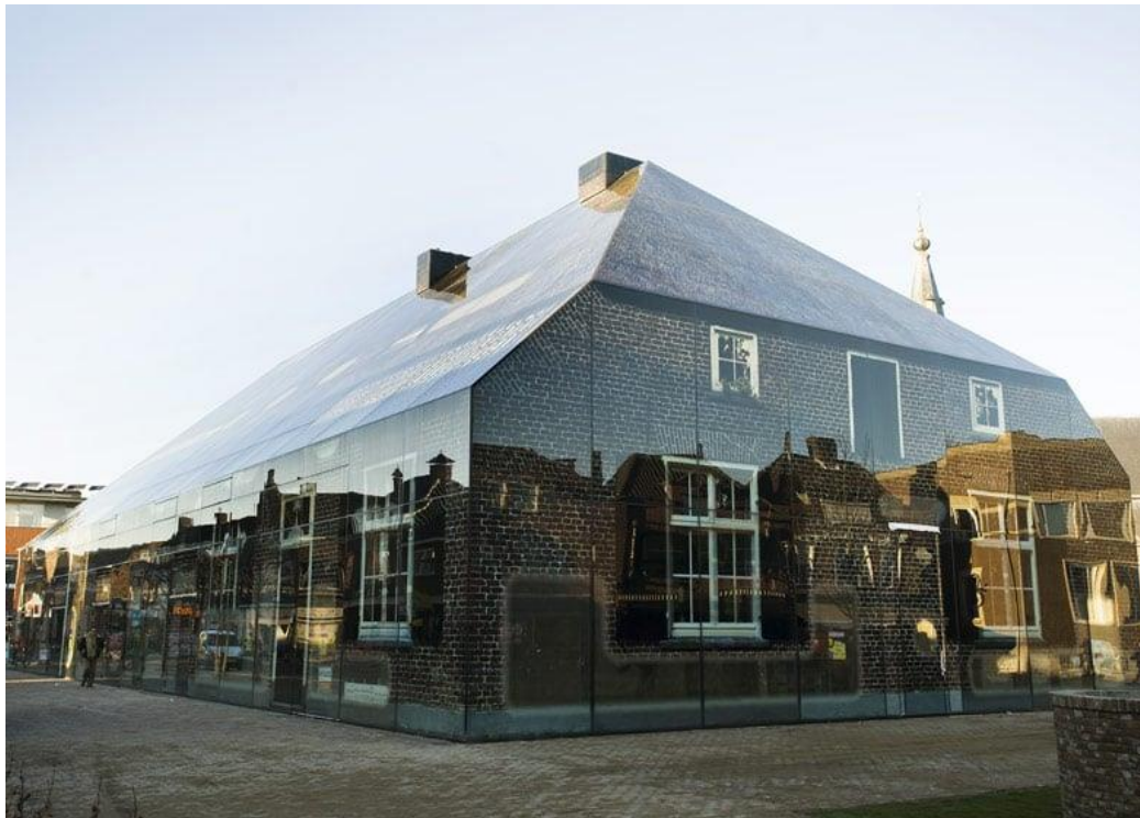
Fotografia 10 Szklana fasada dobudówki na dachu starego budynku Źródło: www.archdaily.com dostępna dnia 25.10.2023
