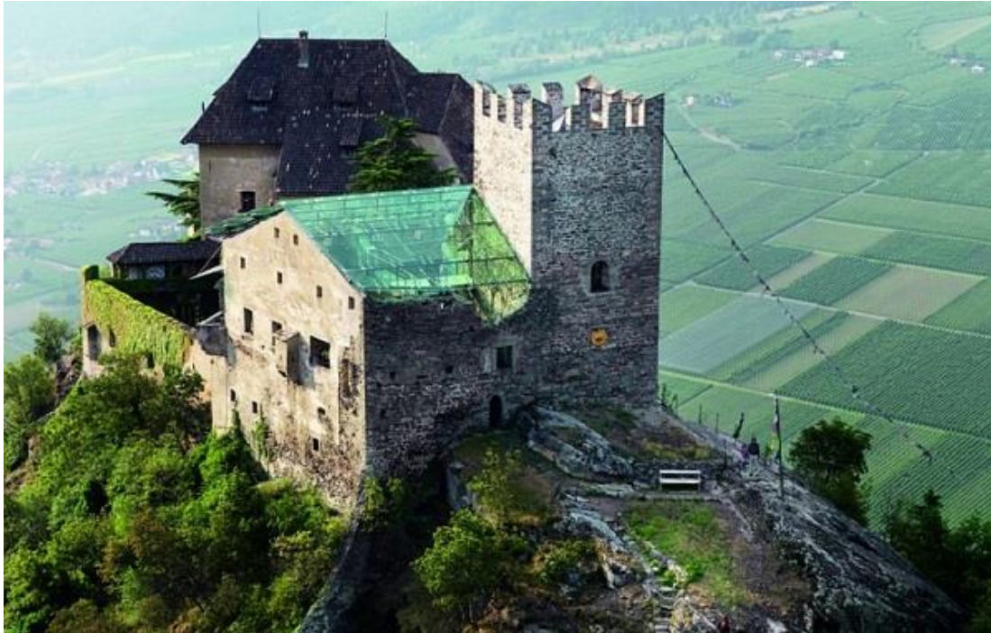
Fotografia 13 Przeszkłony dach zamku Juval- Tyrol Południowy, Włochy Źródło: www.glassonweb.com dostępne dnia 27.10.2023
