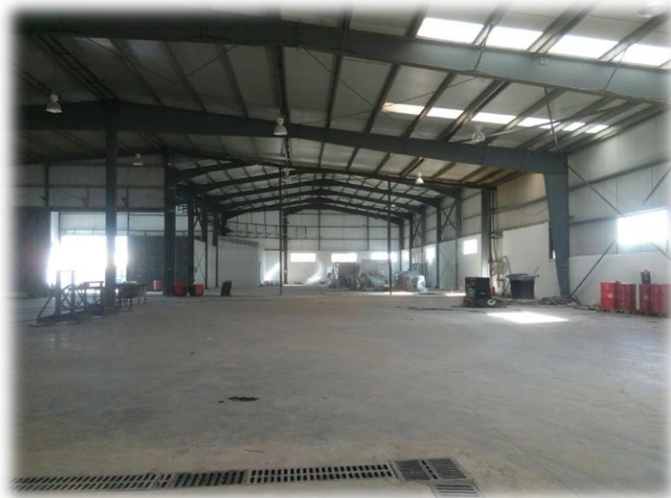
Figure 1- 3 Exemple d'une structure avec ossature principale en PRS(Sétif)
