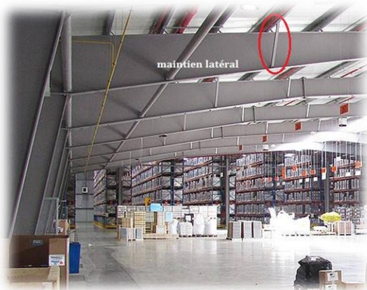
Figure 1- 5 Exemple de maintiens utilisée face au déversement de la traverse
