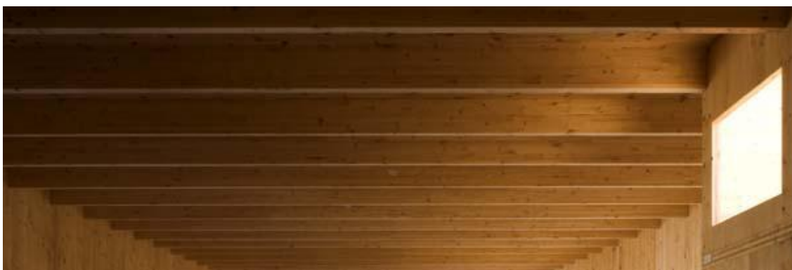
Ilustración 6. Ejemplo de un forjado de CLT T en obra.
